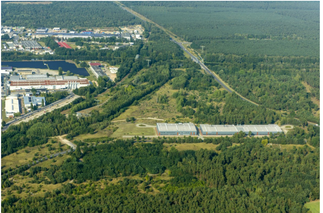
Luftbild Blick nach Norden/Halle des Feuerwehrzentrums
